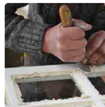
POSE DE VITRAGE ANCIEN AU MASTIC
